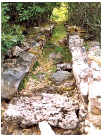
Canal conducción de agua
